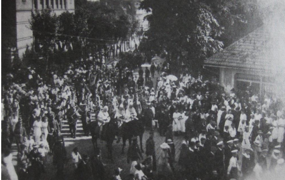
Umzug des „Deutschen Tages“ in Deutsch Eylau, Beginn Bahnhofstraße. Rechts der Kiosk Kaiserstraße 15. 63
